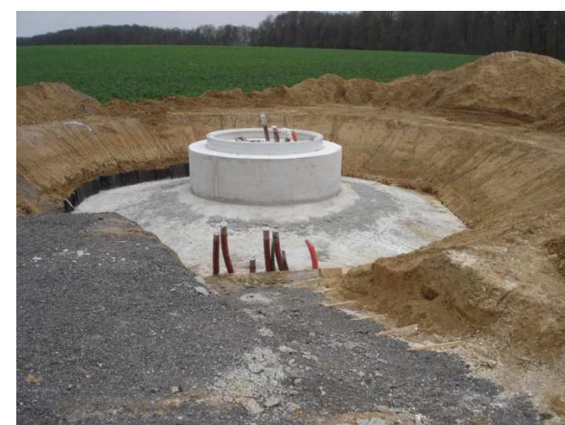
Photo 7 : Béton terminé (Photo : VALOREM)
