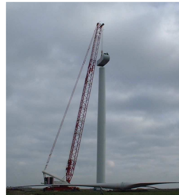
Photo 12 : Installation de la nacelle (Photo : VALOREM)
