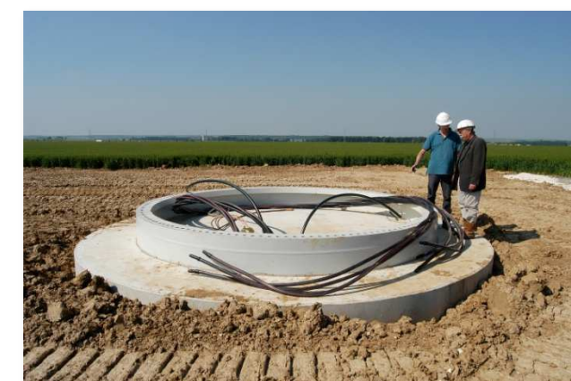
Photo 8 : Fondation terminée (Photo : VALOREM)
