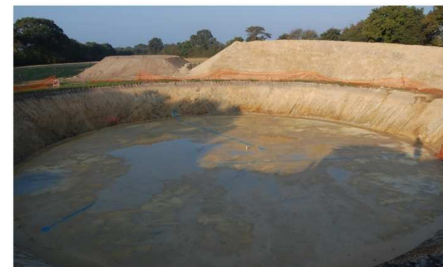
Photo 5 : Excavation (Photo : VALOREM)
