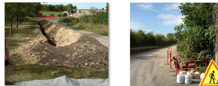
Photo 4 : Tranchée pour le raccordement au réseau local (Source : VALOREM)
